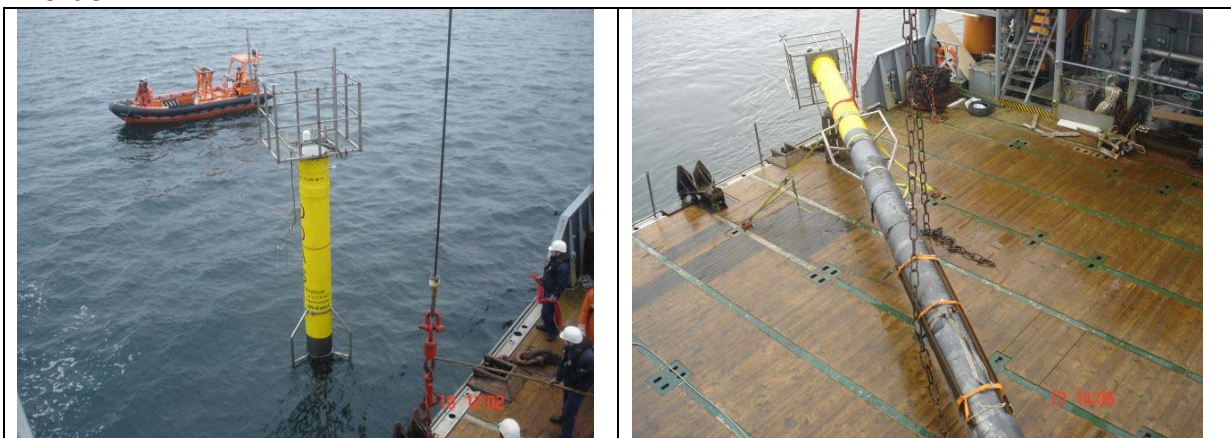
Abbn. 19: Mastbergung am 10.12.2007: der vorgehievte Mast wird mittels Beiboot der ARKONA lagestabilisiert und fixiert. Nachdem er über der Wasseroberfläche in eine fast waagerechte Lage gebracht wurde, erfolgte innerhalb kurzer Zeit das Einschwenken über und das Lagern an Deck (Fotos: Ch. Schygula)
