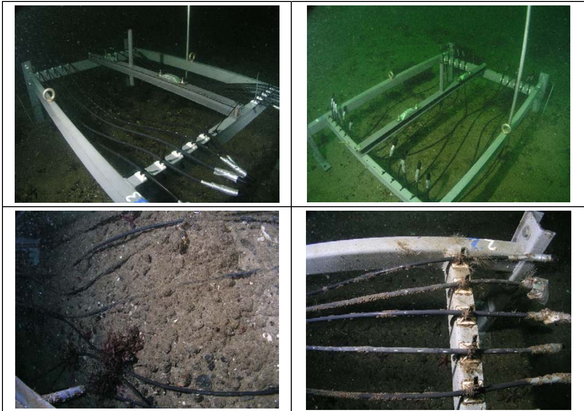
Abbn 11: Kabelprobengestelle – Langzeitversuch seit 9/2007
