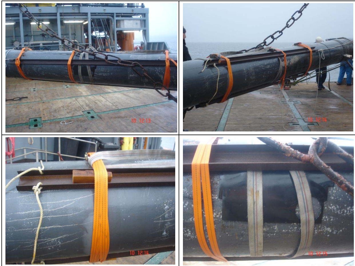
Abbn. 20: Prinzip der Mastschienung zur Sicherung der Rißstelle (Fotos: Ch. Schygula); Foto unten rechts: mit Gurtband befestigtes Lecksegel
