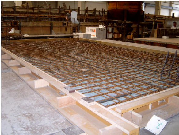
Abb. 2: Betonspezialelement „Algen-Tisch“ bei der Herstellung
