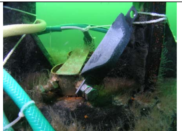
Abb. 4.3b: Befestigung von Opferanoden an der Sicherungsvorrichtung des Kreuzgelenkes
