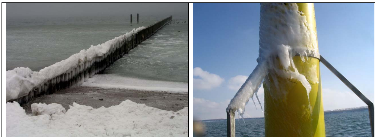
Abbn. 3.3.: Vereisungssituation im Januar 2006 in Nienhagen am Strand und am Telemetriemast
