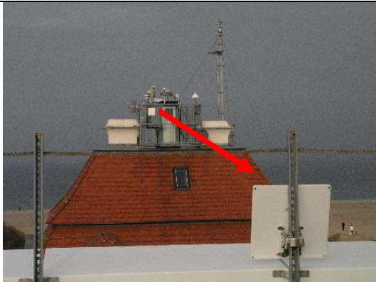
Abbn. 3.9: Anordnung der WLAN-Antennen beim DWD und IOW
