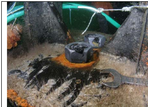
Abb. 4.3a: Zustand nach UW-Schweißung
